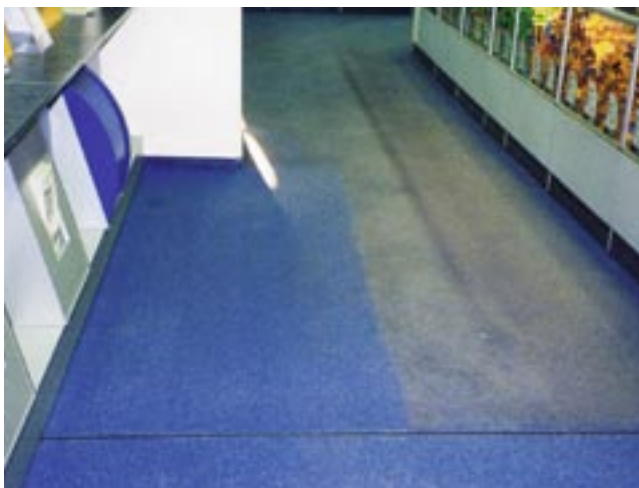
Reinigung schwieriger Steintepiche.
