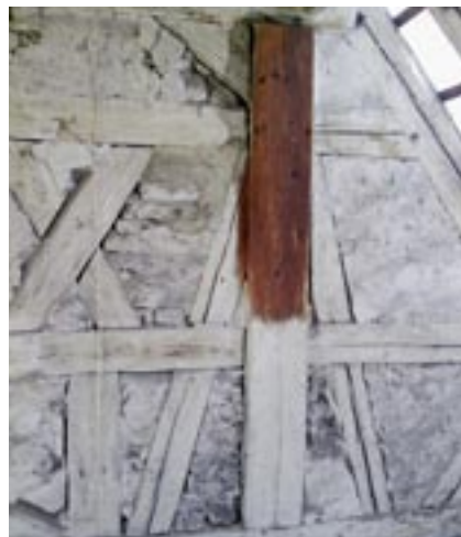
Reinigung gekalkter Holzbalken.
